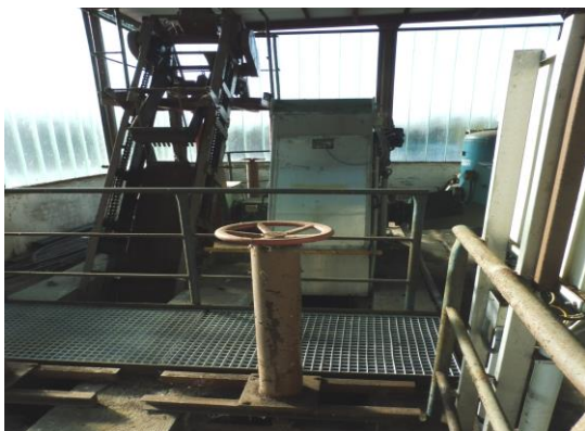
Hrubé předčištění – strojní česle
